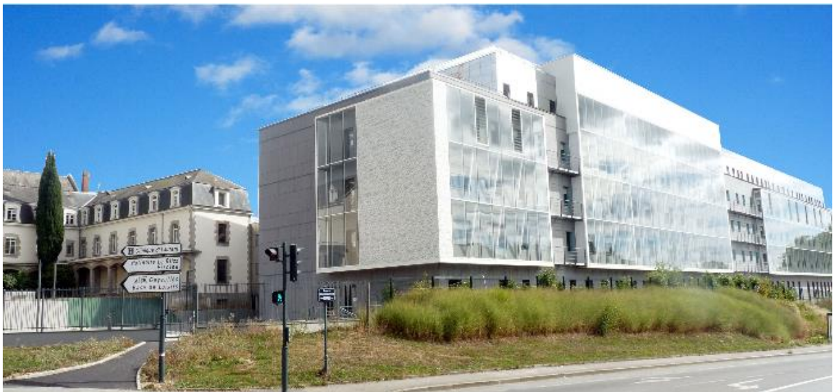
Le nouveau bâtiment accueillant l'unité d'hospitalisation de médecine post-urgences
